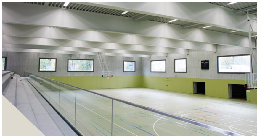
Einblick in die neue Turnhalle
