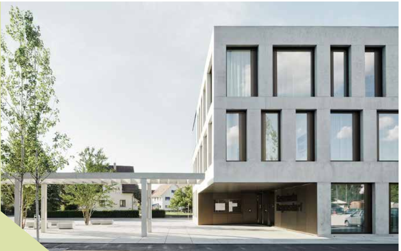
Der repräsentative Neubau der Gemeindeverwaltung Regensdorf.
