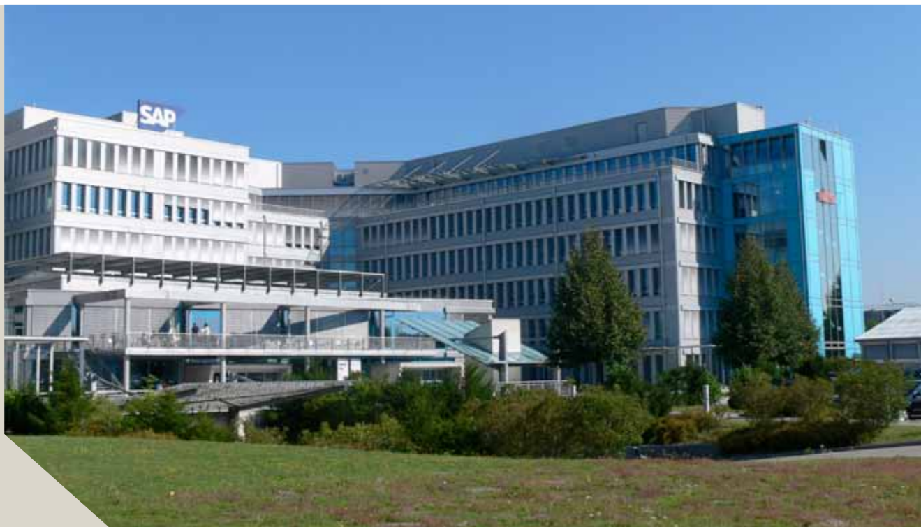
Teil des Gretag Areals in Regensdorf.
