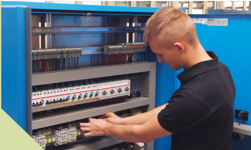
Lourens Andrée, Lernender Automatiker, bei Aufbau und Verdrahtung von Schaltanlagen
